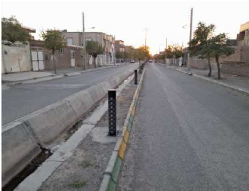
شکل ۹. تصاویری از هدایت آب‌های سطحی توسط ایجاد کانال‌های منظم و استاندارد در روستاهای دهستان رشتخوار
